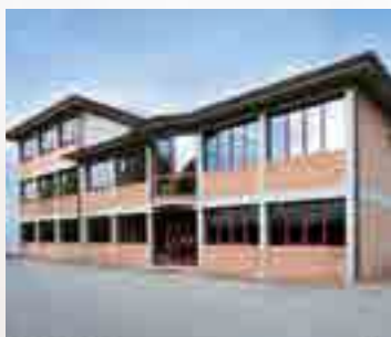
Siège de Tecno-Gaz Sede de Tecno-Gaz
