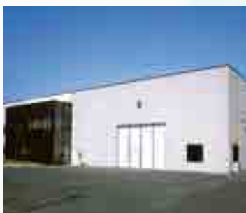
Fabrique 2 Tecno-Gaz Fábrica 2 Tecno-Gaz
